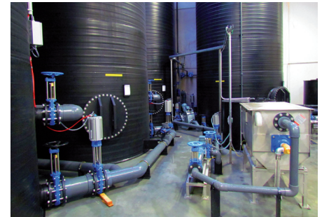
Umweltgerecht: Ein eigener Reinigungswasserkreislauf mit integrierter chemisch/physikalisch/biologischer Brauchwasserreinigung minimiert den Wasserverbrauch.
